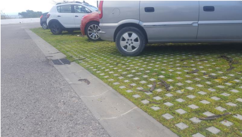
Figur 9. Bilparkering med armerat gräs som beläggning.
