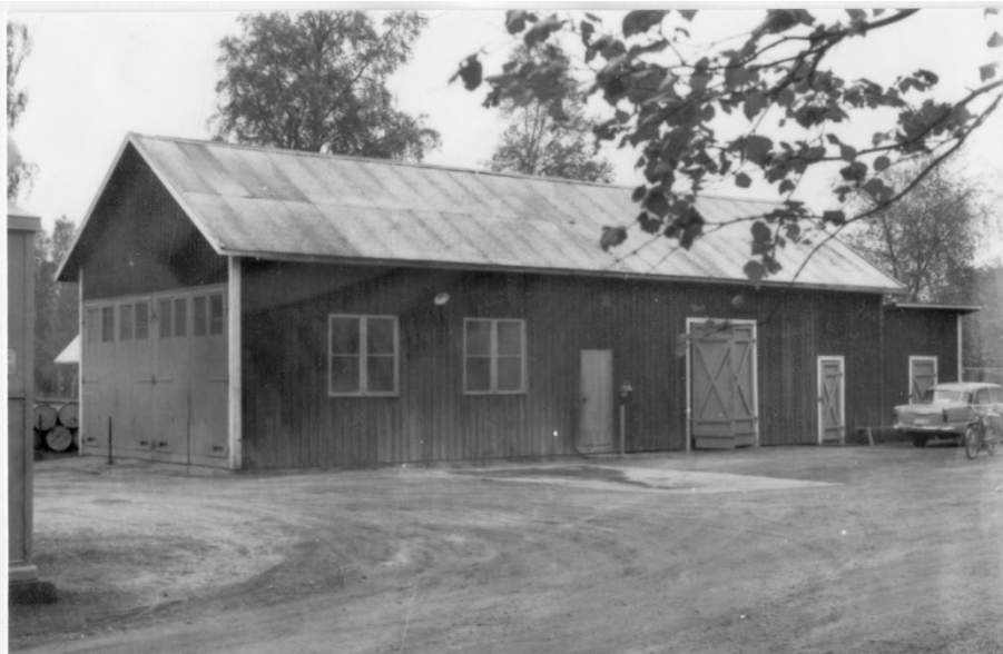
Figur 10. Vägstation Y3, Matfors, filial Njurunda." Garage- och förrådsbyggnad. Fotat mellan 1960-1970. (Sundsvalls museum)
