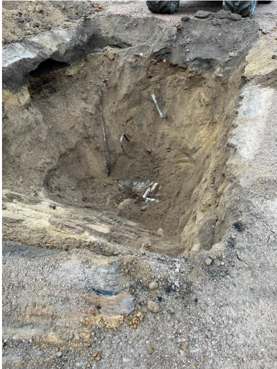
FIGUR 8. FOTO FRÅN NORDOST SOM VISAR PROVGROP I PROVPUNKT 23VM06. NOTERA BETONGPLATTA, FÖRANKRINGSBAND OCH BRÄNSLELEDNING.
