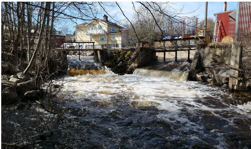
Figur 13. Damm 2. Fotot är taget på dammens nedströmssida i uppströmsriktning.
