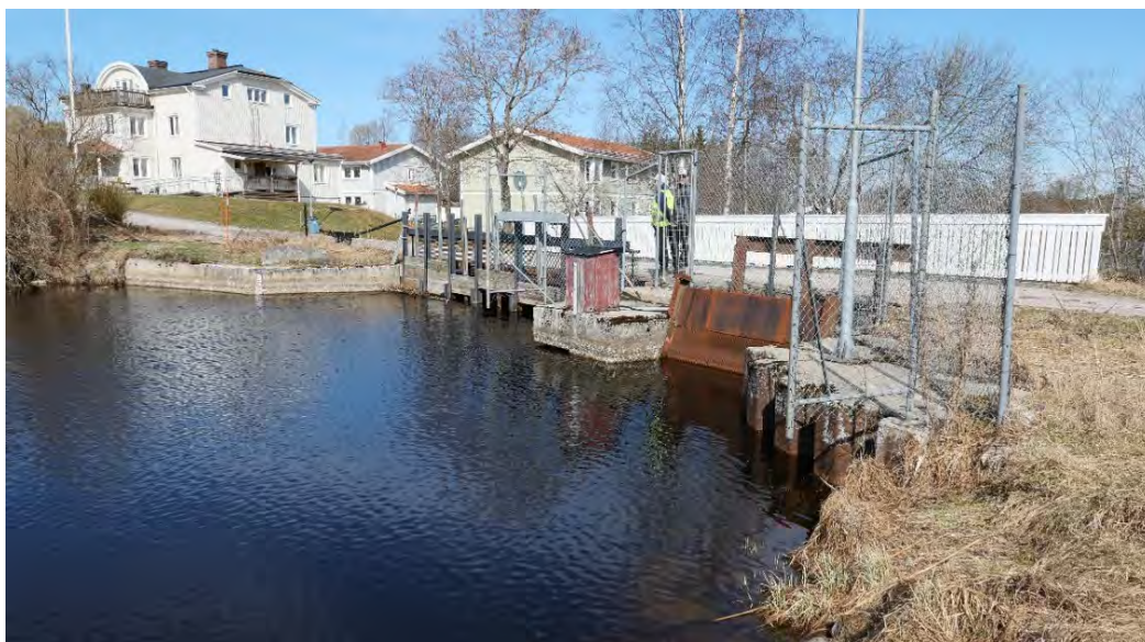
Figur 15. Damm 4. Fotot är taget på dammens uppströmssida i nedströmsriktning.
