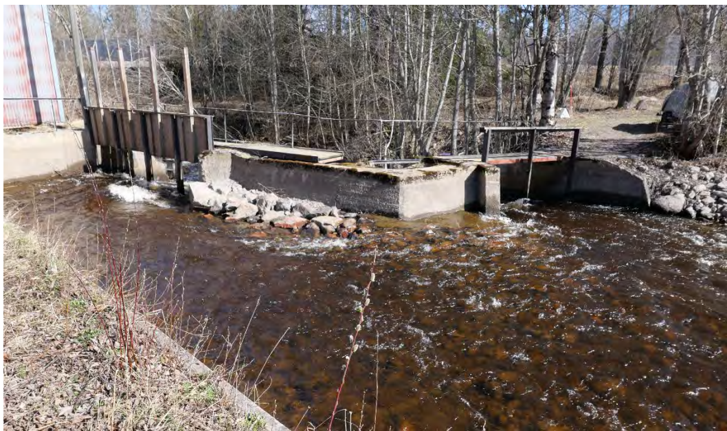
Figur 12. Damm 2. Fotot är taget på dammens uppströmssida i nedströmsriktning.
