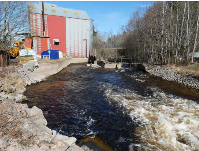
Foto över damm 2. Fotot är taget i nedströms riktning
