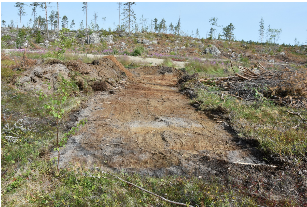
Figur 4. Schakt direkt söder om bergåsen sett från S.
