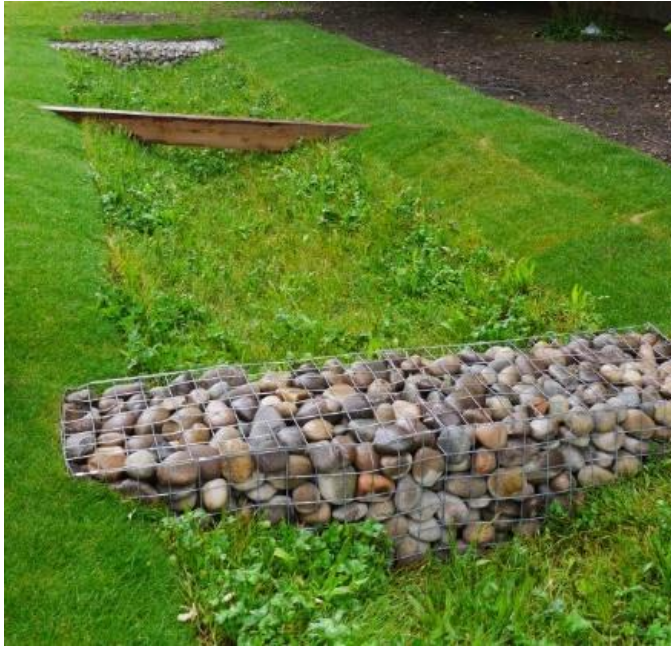
Figur 11. Svackdike med dämmande sektioner (Boverket, 2019)
